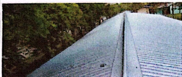
Foto1: Sustitución de lamina por lamina troquelada
